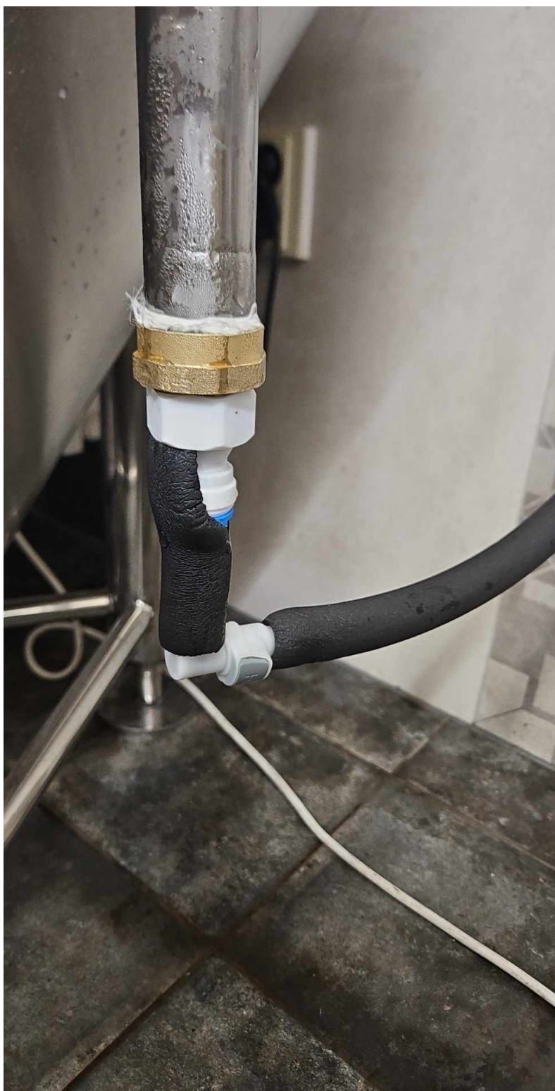
Detail hadic s napojenou izolaci.
